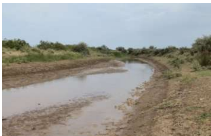
Şəkil 1. Vəlvələçayın mənsəbə yaxın hissəsində görünüşü.
